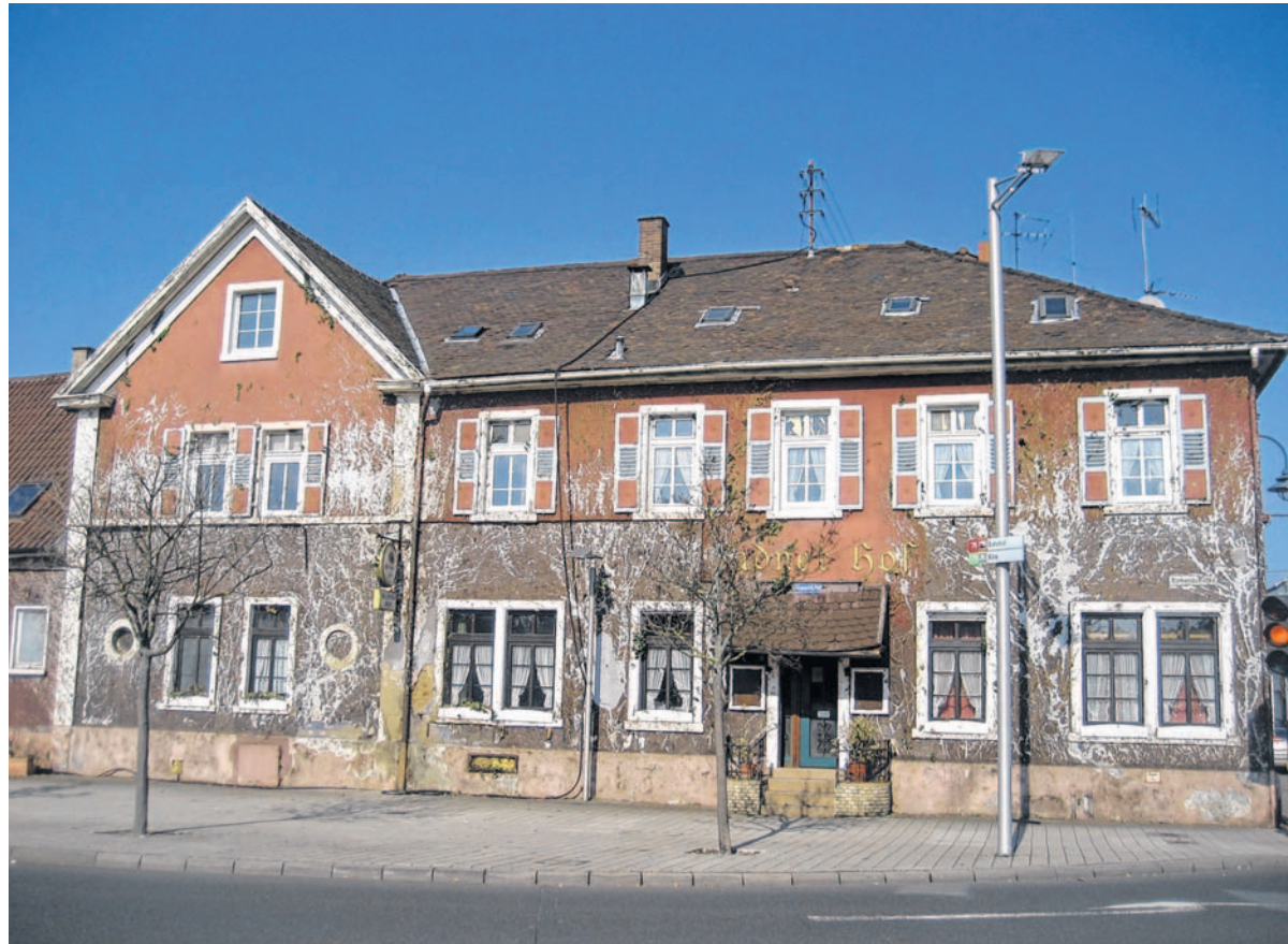
Der „Badner Hof“ kommt in neue Hände. Bianca Ramosaj will hier ein Bistro eröffnen. Die Innenausstattung soll erhalten bleiben, aber außen erhält das Haus einen neuen Anstrich. BILD: KYRBERG
