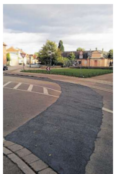
Die Überquerung des Radweges am Dreibrückentor (Maschinenweg): der rote Belag, der den Radweg markiert, wurde überleert. BILD: BAURTOH
